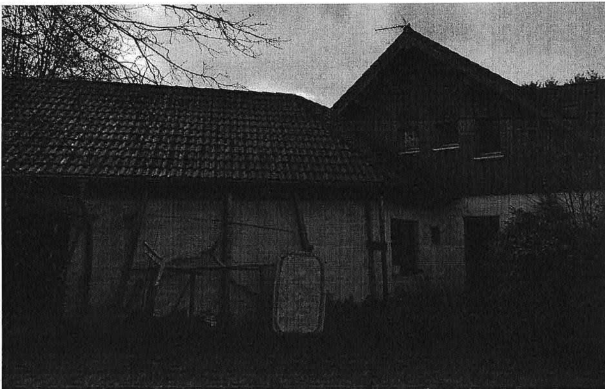
Abbildung 4: Blick auf Garage mit Blick aus Richtung Norden
