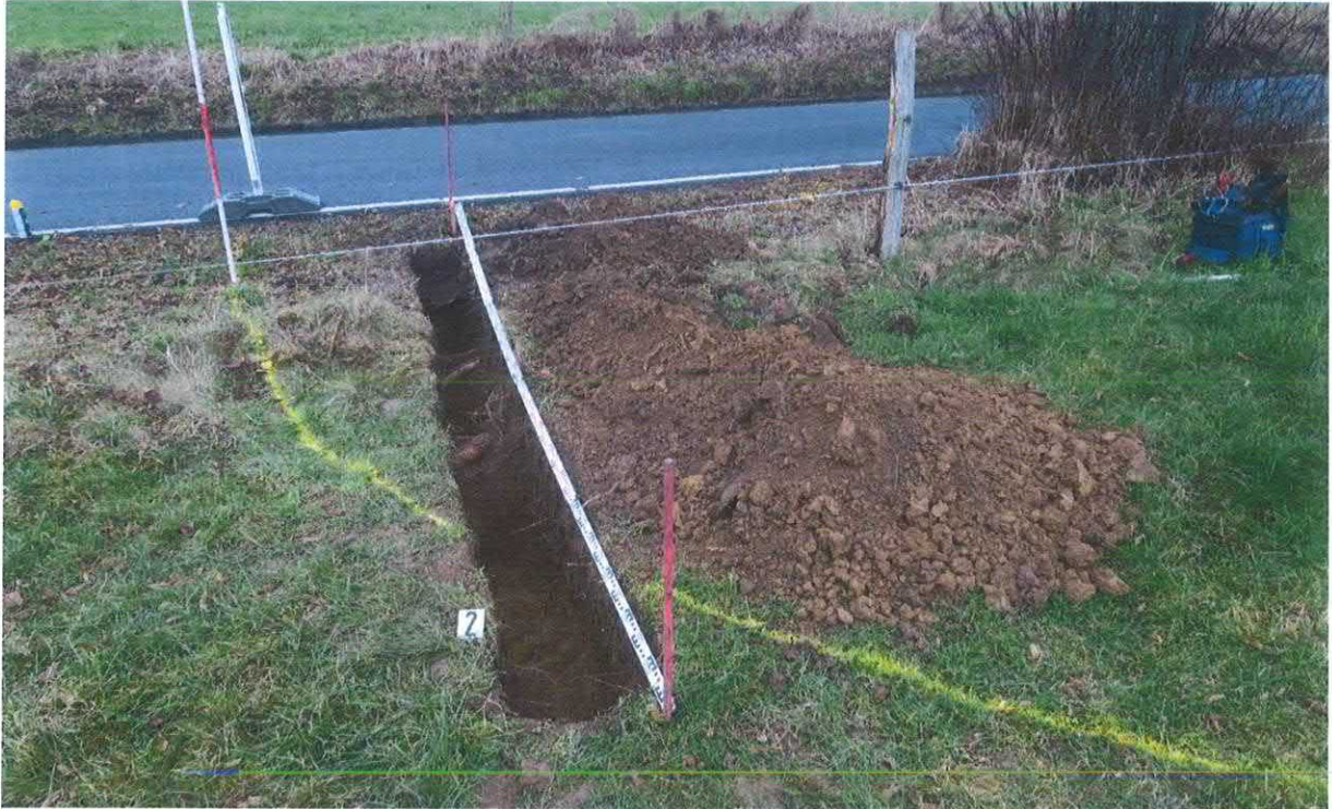
Abb. 12: Ansicht Sondierungsgraben Bereich Linde, Baum Nr. 2.
